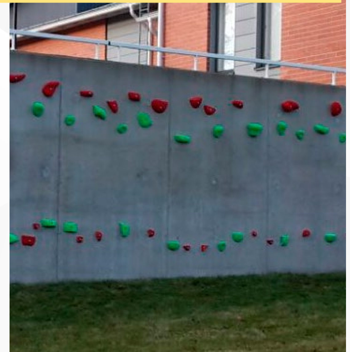
BETONIMUURIIN KIINNITETYT OTTEET
